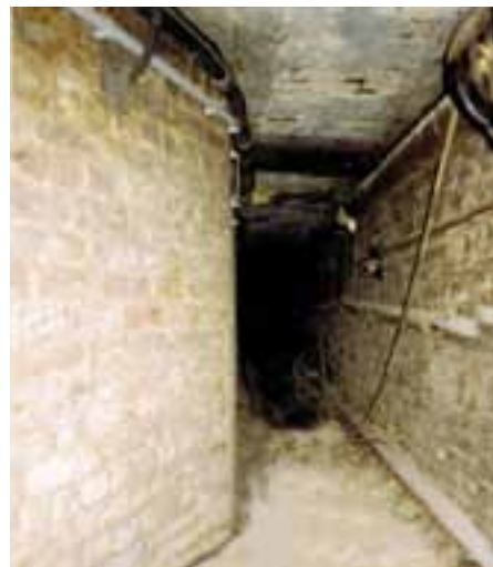
Links: Bunker im Jahre 1997, Originaltür und stabile Doppel-T Stützen. Der Bunker war zur Kriegszeit gasdicht.
