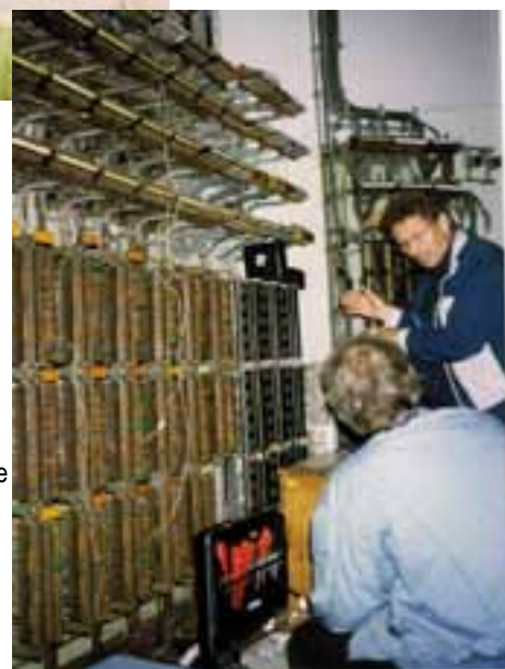
Rechts: Der damalige Leiter Wolfgang Beschoner an einem neuen Schaltschrank. Foto : Stenzel, 1997
